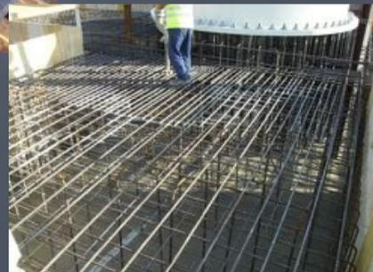
Caratterizzati da una elevata resistenza alla segregazione, sono particolarmente indicati per opere con geometrie complesse o fittamente armate, in quanto, l'elevata capacità di scorrimento, permette al conglomerato di distribuirsi in maniera omogenea adattandosi perfettamente alla cassaforma di contenimento.
